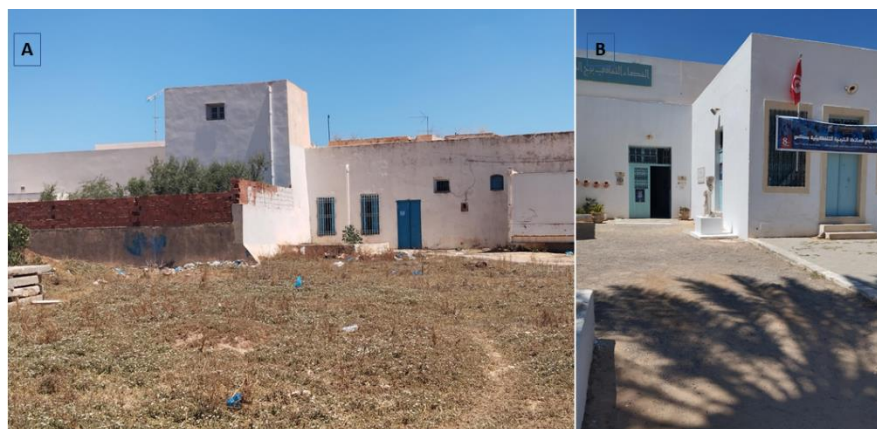
Photo 2. Des Borjs dans la zone résidentielle de l'agglomération de Sfax ; A) Borj abandonné et B) bâtiment transformé en espace culturel (sources : Ghribi, mai 2025). Borjs in the residential area of the agglomeration. (A) Abandoned Borj and (B) building transformed into a cultural space (photos taken by Ghribi in May 2025).
