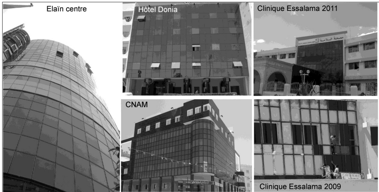
Figure 10 : Exemple de bâtiments vitrés à Sfax (Clichés : S. Dahech, 2009 et 2011). Example of glazed buildings in Sfax (Dahech pictures recorded in 2009 and 2011).
